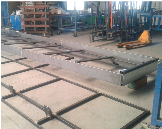
La disposition de la structure en atelier avant peinture.
