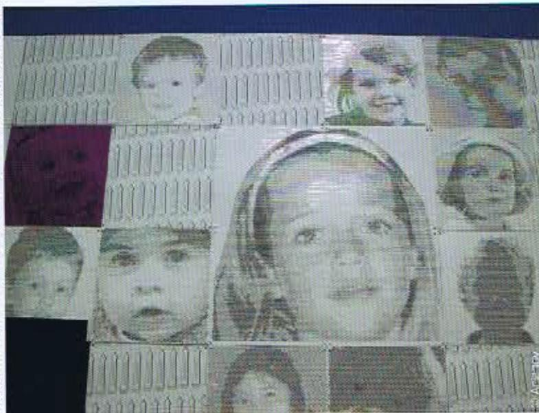
Façade d'une école de Châteaupié (35) réalisée en tôle perforée par Acianov et posée par la métallerie ADMS.
